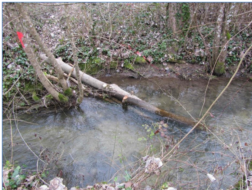
ELEMENTS DE BOIS MORTS INTEGRES AU LIT MINEUR POUR DIVERSIFIER LES ECOULEMENTS
